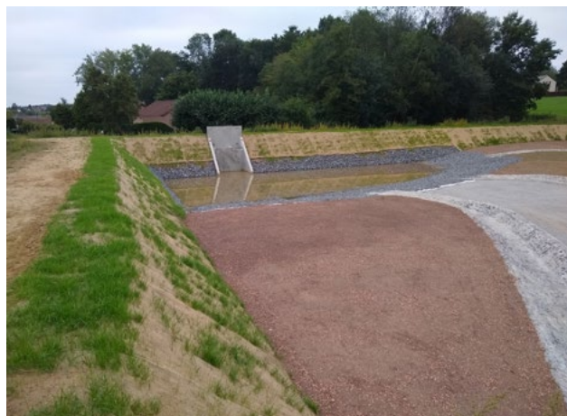
Aanleg bufferbekken bedrijventerrein Keiberg-Vossem Tervuren
