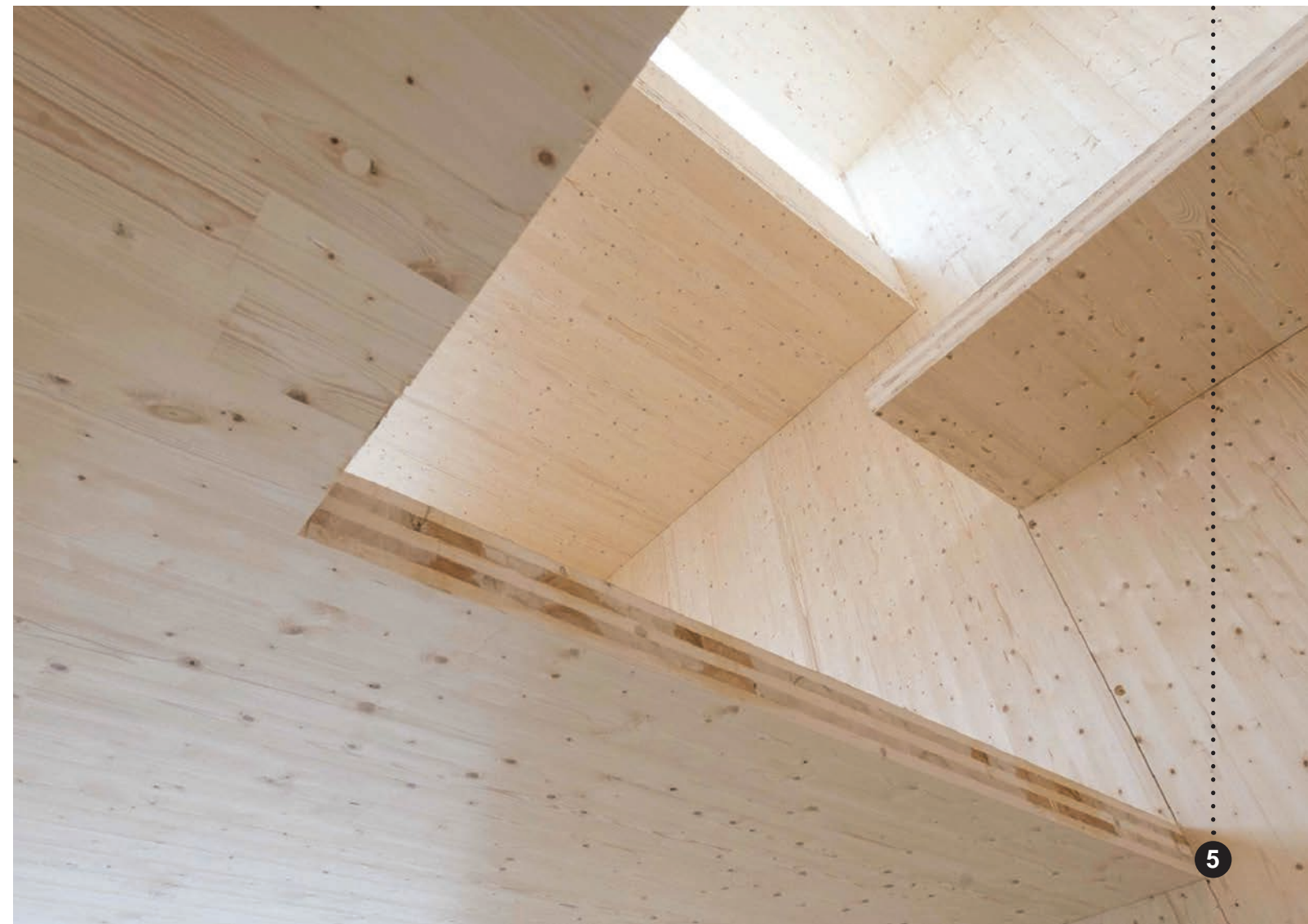
Afb. 3 CLT woning in aanbouw, Gent. reArch architecten Bron: www.houtcreaties.com
