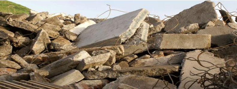
Beton bij sloopwerkzaamheden
