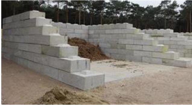
Figuur 12 Betonblokken stapelblokken (Akkebouw, 2014)
