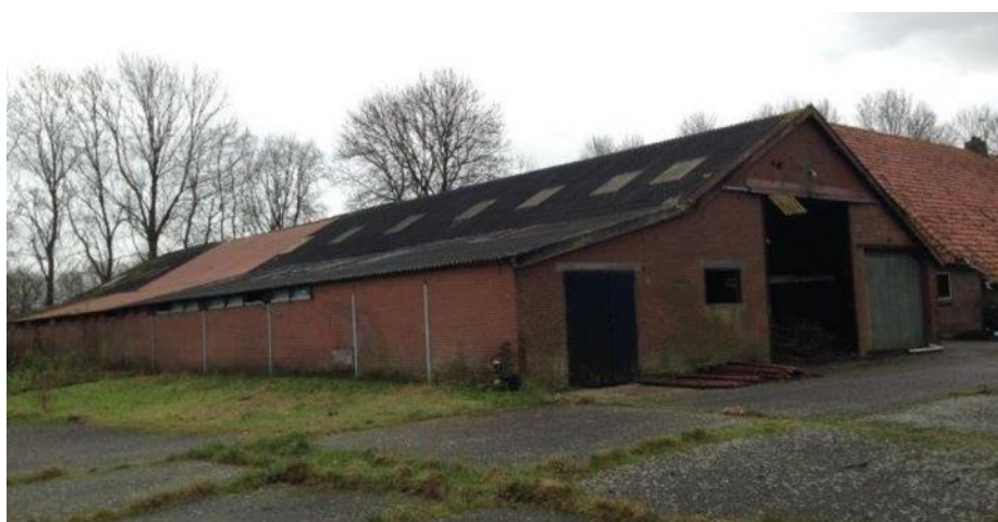
Figuur 5 Stal met asbestpanelen (Gebr. Middelveld BV, 2015)
