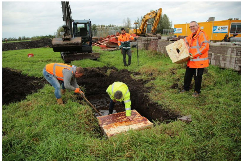
Afbeelding 2: Pilot met volledig natuurlijk ophoogmateriaal – Groene Hart werkt
