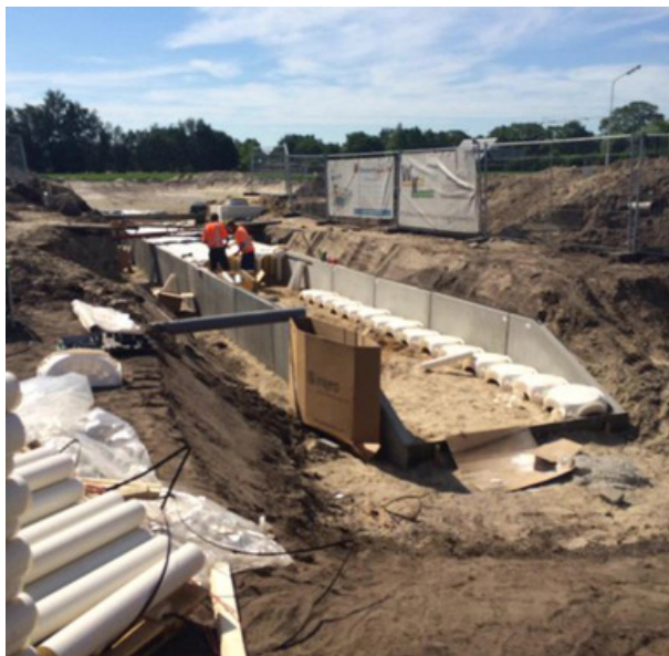
Aanleg faunaduiker met verloren bekisting (bron: Mark Vissers)
